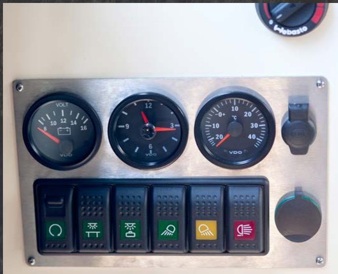
▲ Extra: Das Bedienpanel in der Kabine ist nur gegen Aufpreis erhältlich, einen Batteriemonitor montiert Matzker aus Überzeugung nicht.
